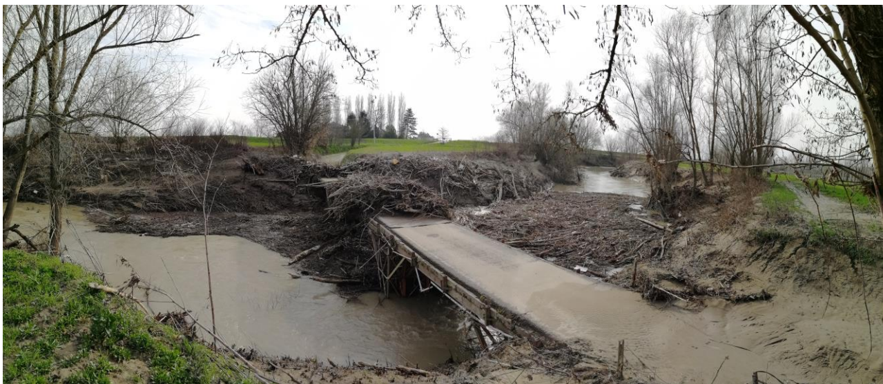
Ponte di Castelnovo prima della demolizione
