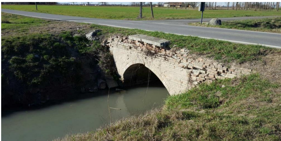
Ponticello prima dell'intervento
