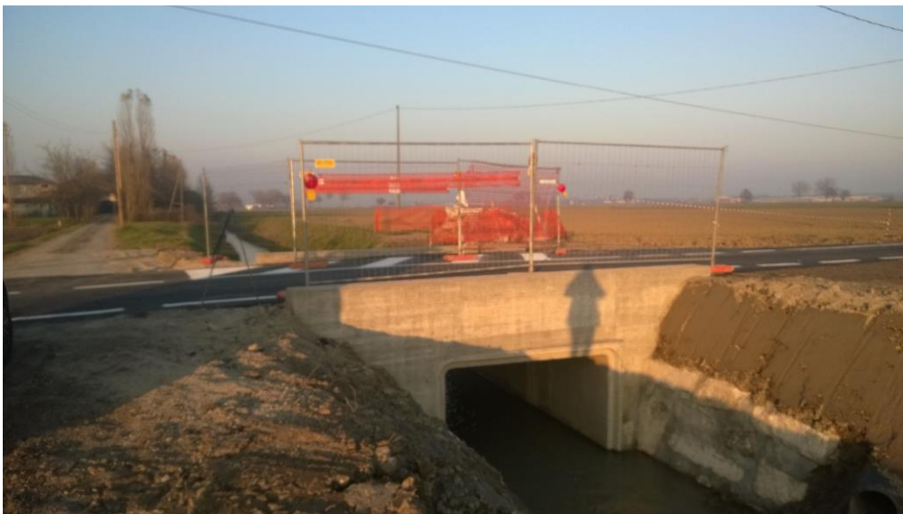
Ponticello in fase di ultimazione dell'intervento di manutenzione
