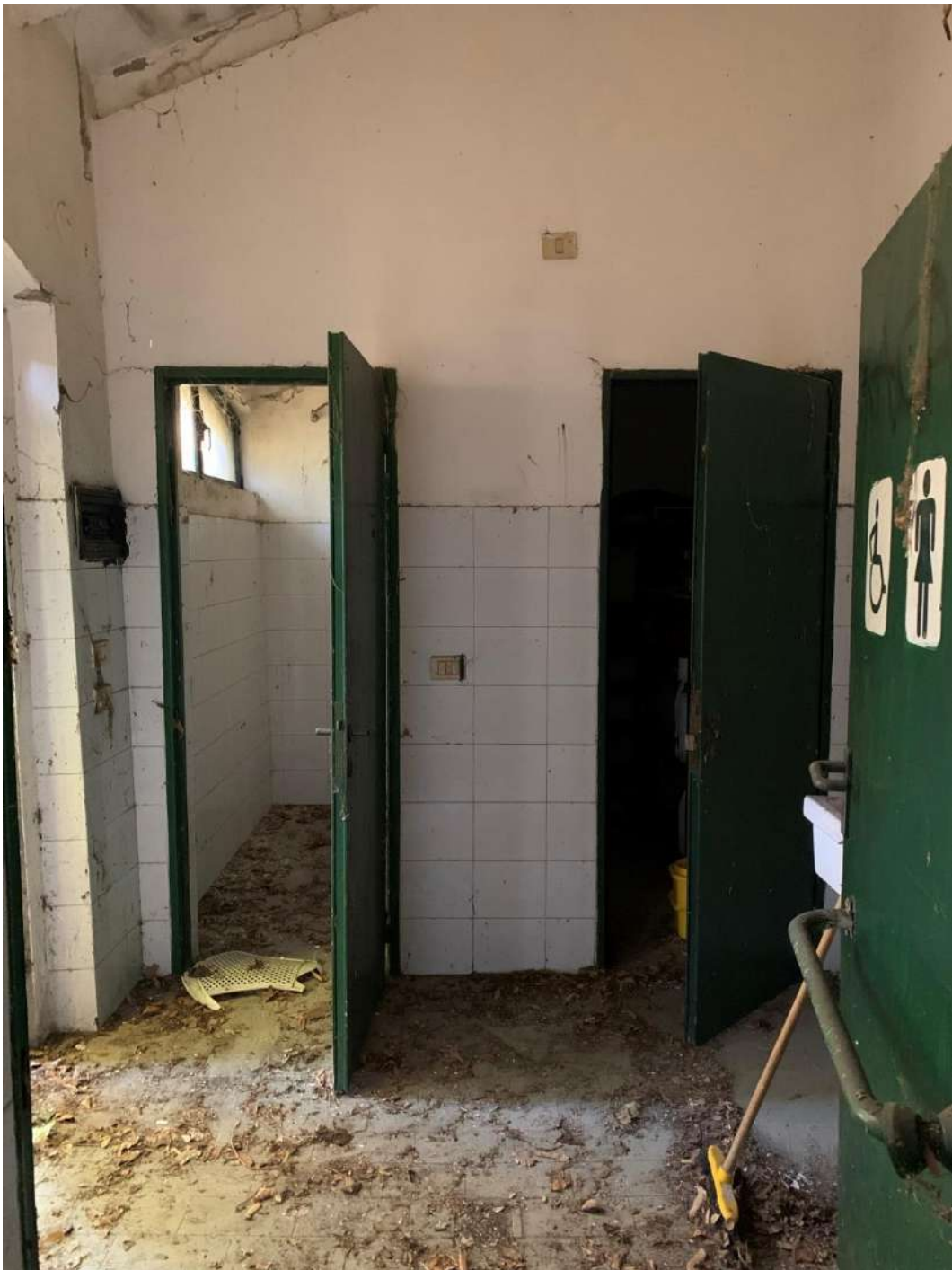
Vista interna servizi igienici
