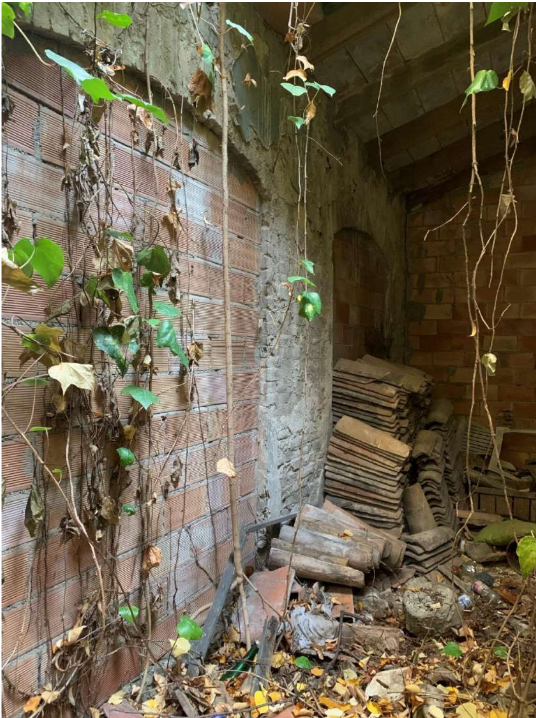
Tamponamento in forati delle aperture esistenti
