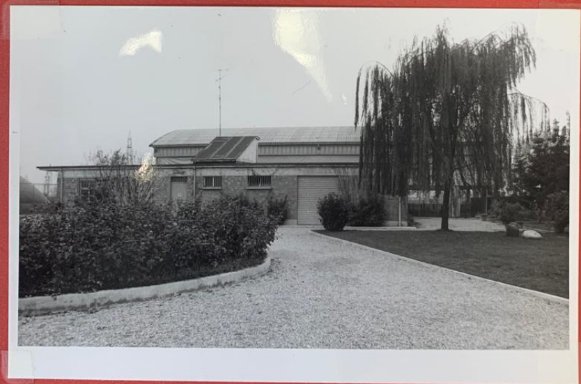
..... il prospetto orient con le pelliabine spogliatoi.
