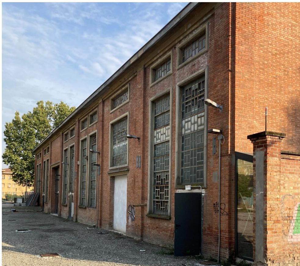
Manica Nord - fronte Nord
