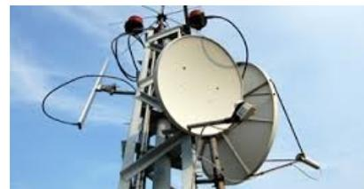
Gli impianti centralizzati d'antenna sono anche conosciuti come sistemi MATV (Master Antenna Television) e SMATV (Satellite Master Antenna Television). I primi vengono usati per la distribuzione dei segnali terrestri, mentre nei secondi vengono distribuiti i segnali ricevuti da satellite, eventualmente combinati con i segnali terrestri. Essi rappresentano un mezzo per la condivisione delle risorse tra diversi utenti ai fini della fruizione dei servizi e possono contribuire.
