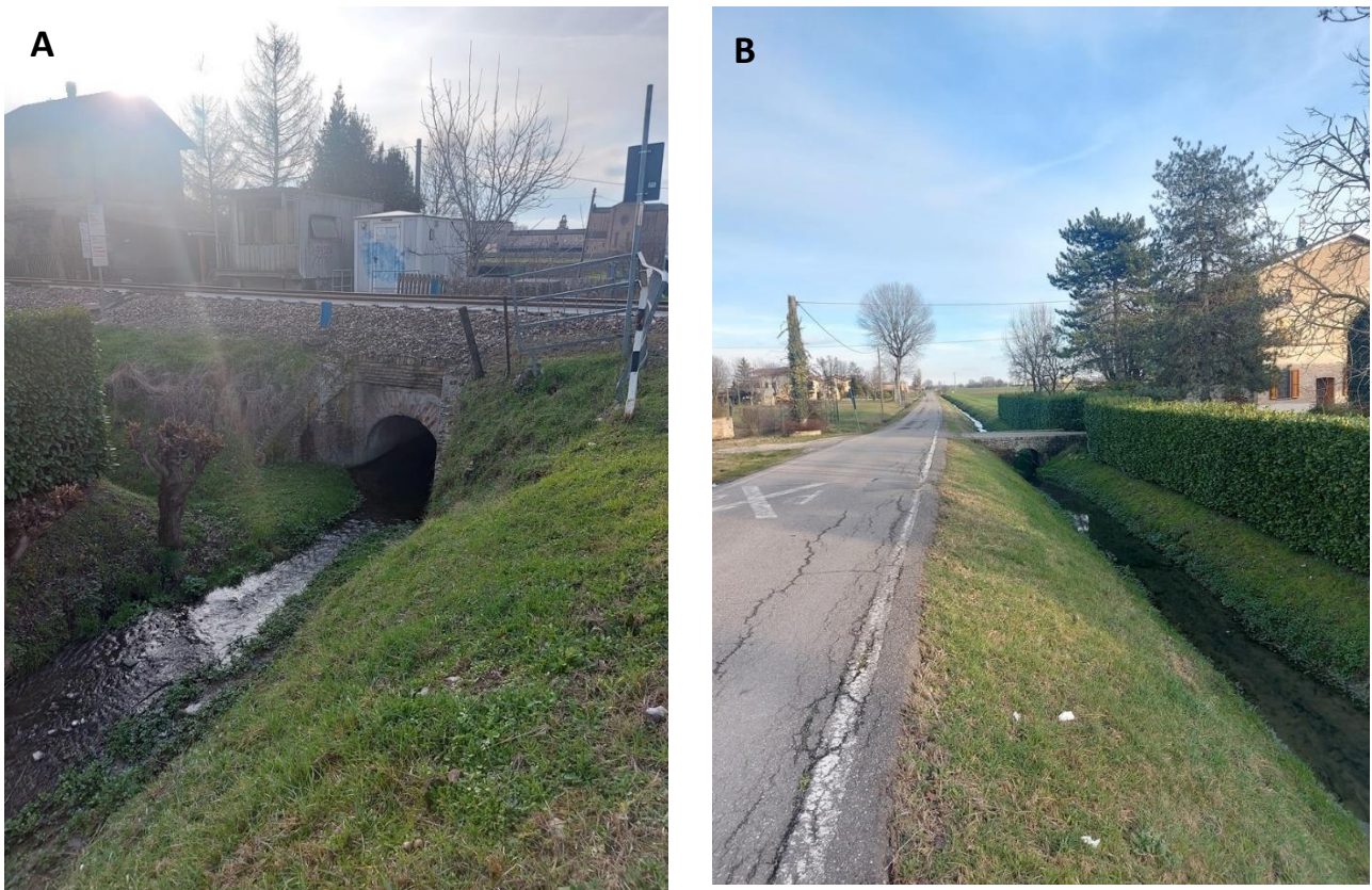
Figura 13 - A) Manufatto attraversamento ferrovia M04 - B) Attraversamento M05
