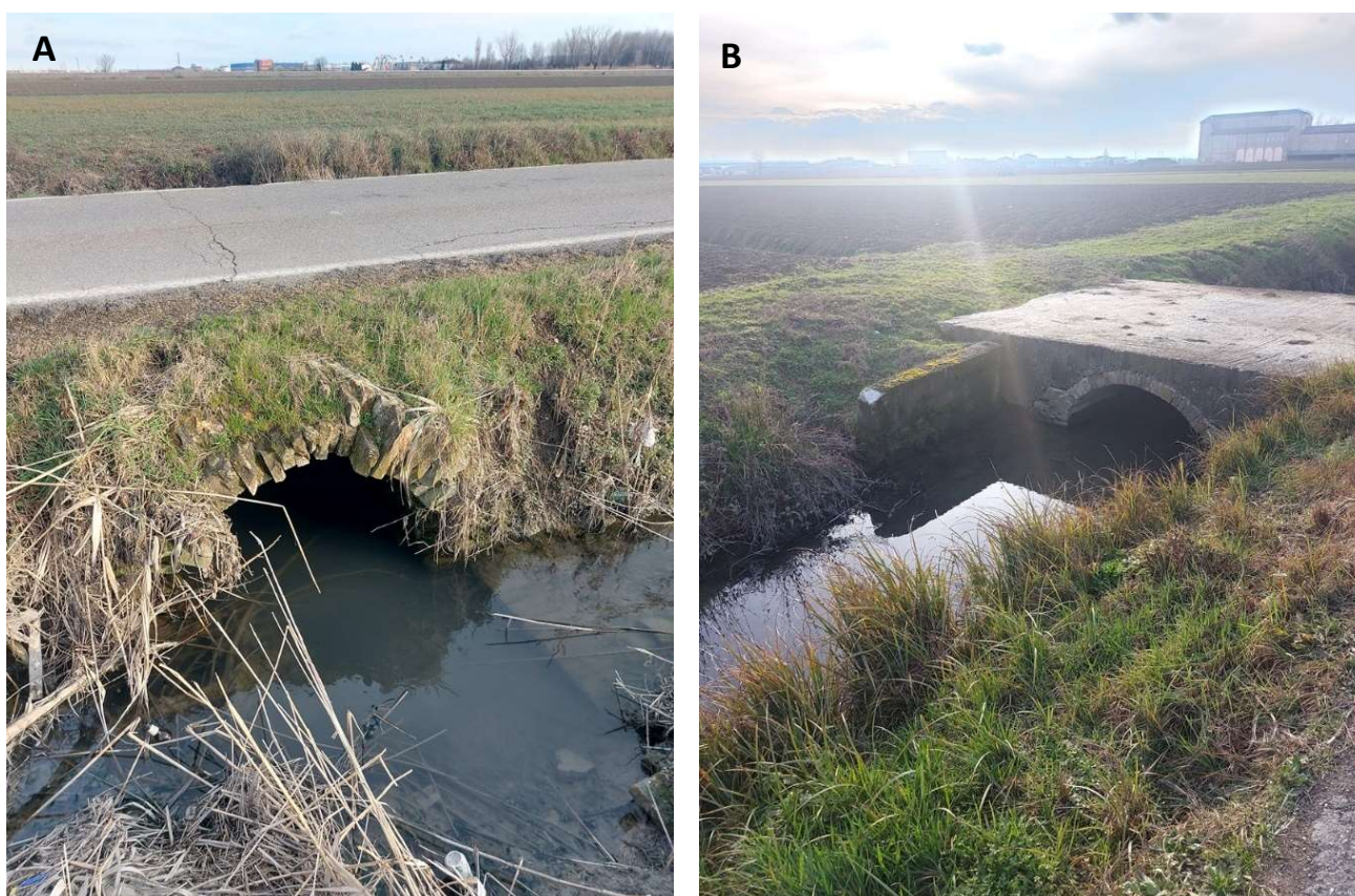
Figura 2 - Stato di Fatto A) Manufatto M02 - B) Manufatto M03
