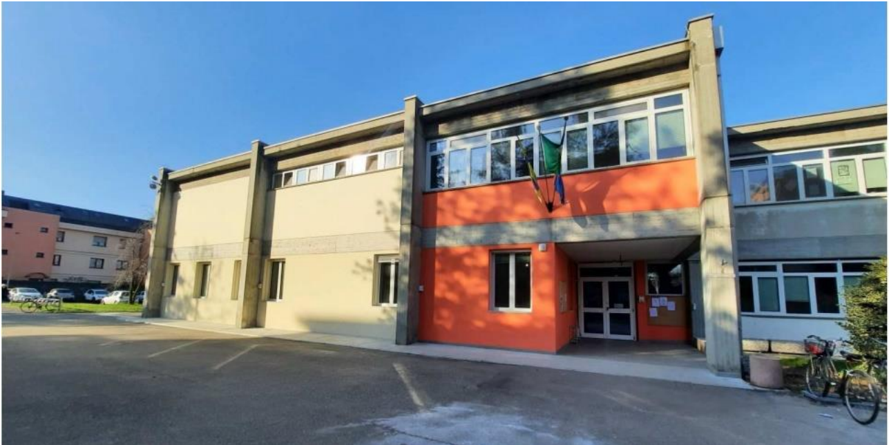
Ingresso principale al plesso scolastico
