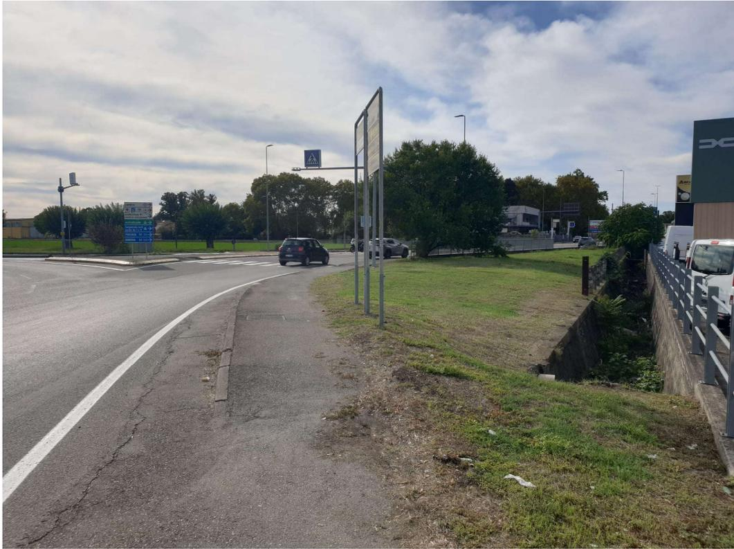
**Figura 15 – Parapetto mancante attorno al canale**
