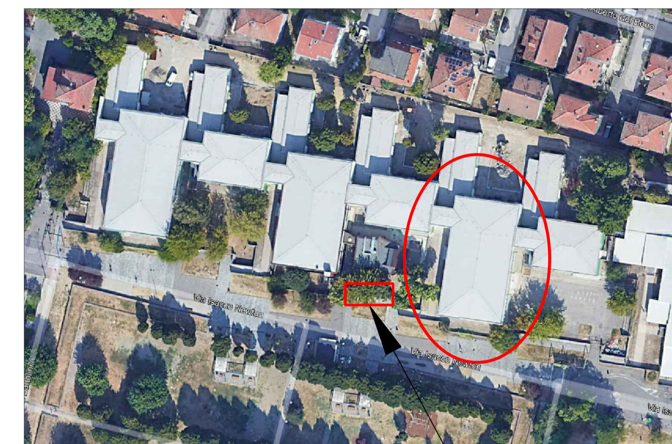
AREA INVERTER E QUADRO FOTOVOLTAICO
