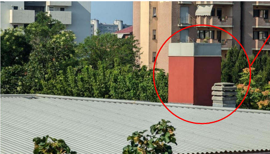
Camino in copertura fabbricato centro
