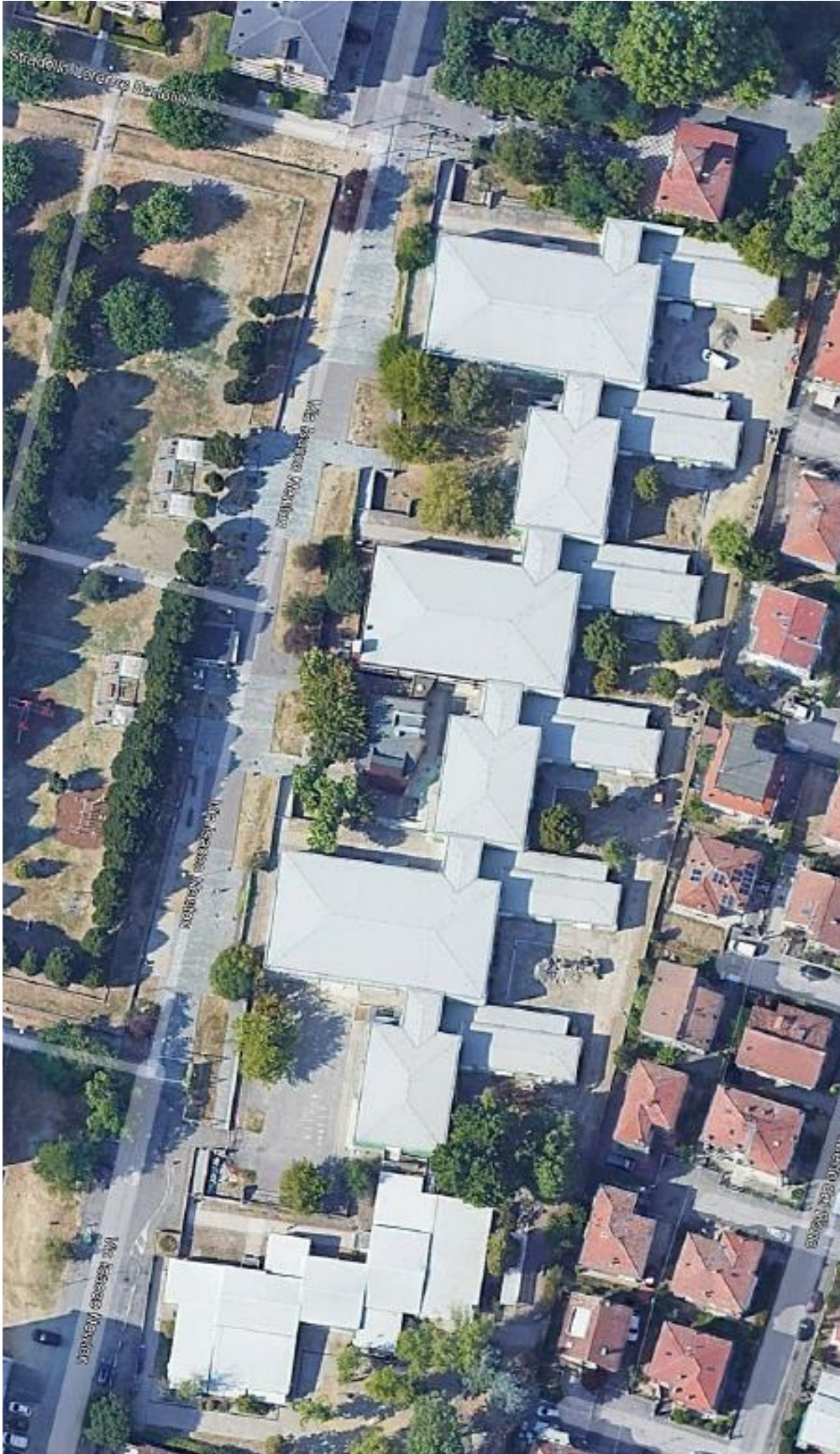
Foto della Nuova Copertura su cui si installeranno i pannelli Fotovoltaici
