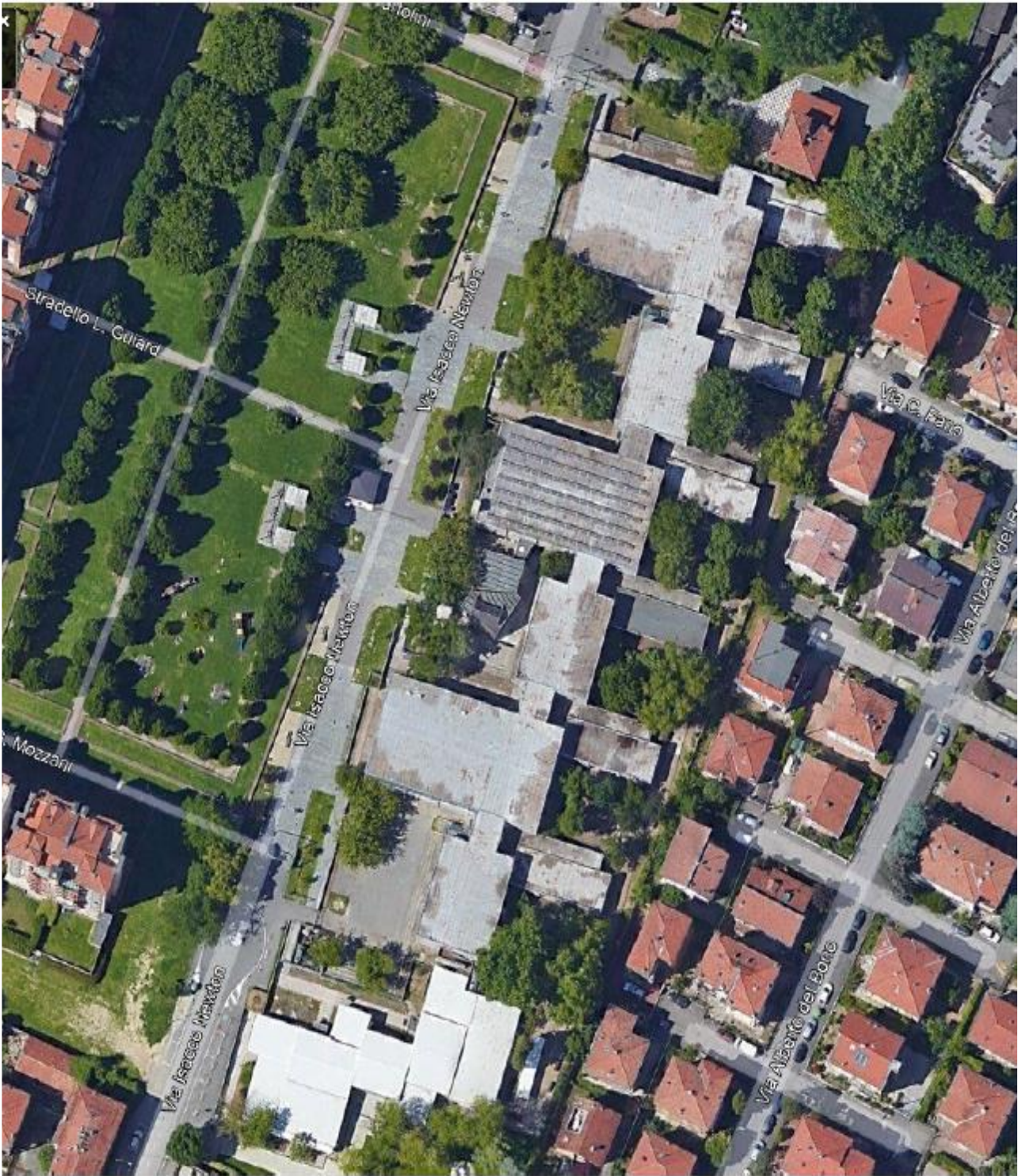
Foto copertura Ante sostituzione EF.EN.
