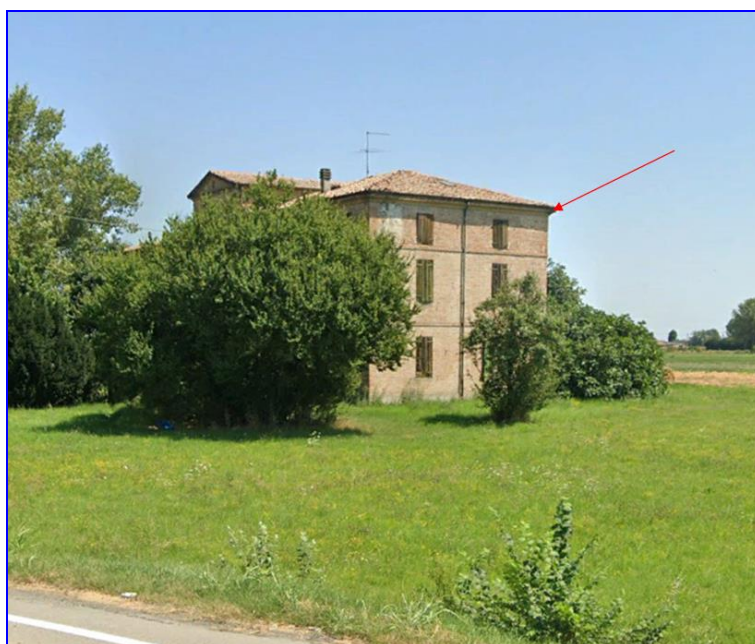
Fotografia 8 int – Punto Caposaldo 03, fotografia dalla rotonda di Via Benjamin Franklin e SP72
