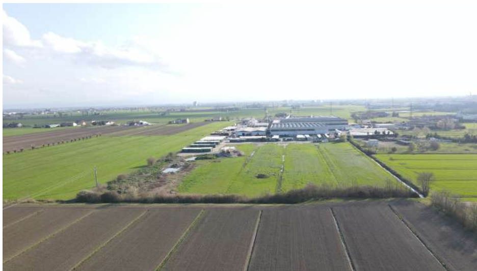
Figura 35: Foto pre- intervento
