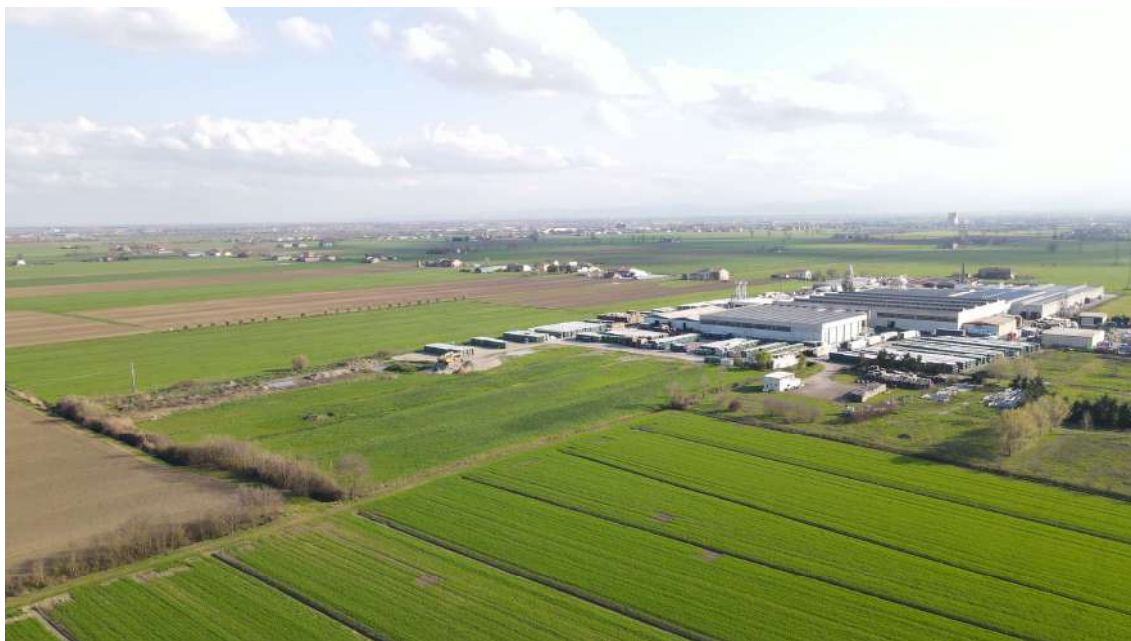
Figura 12: Vista fotografica Nord - Ovest dello stabilimento
