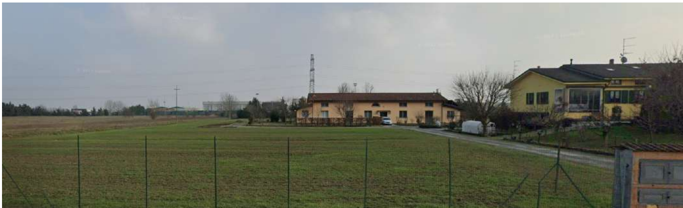
Figura 15: Vista da Strada Burla
