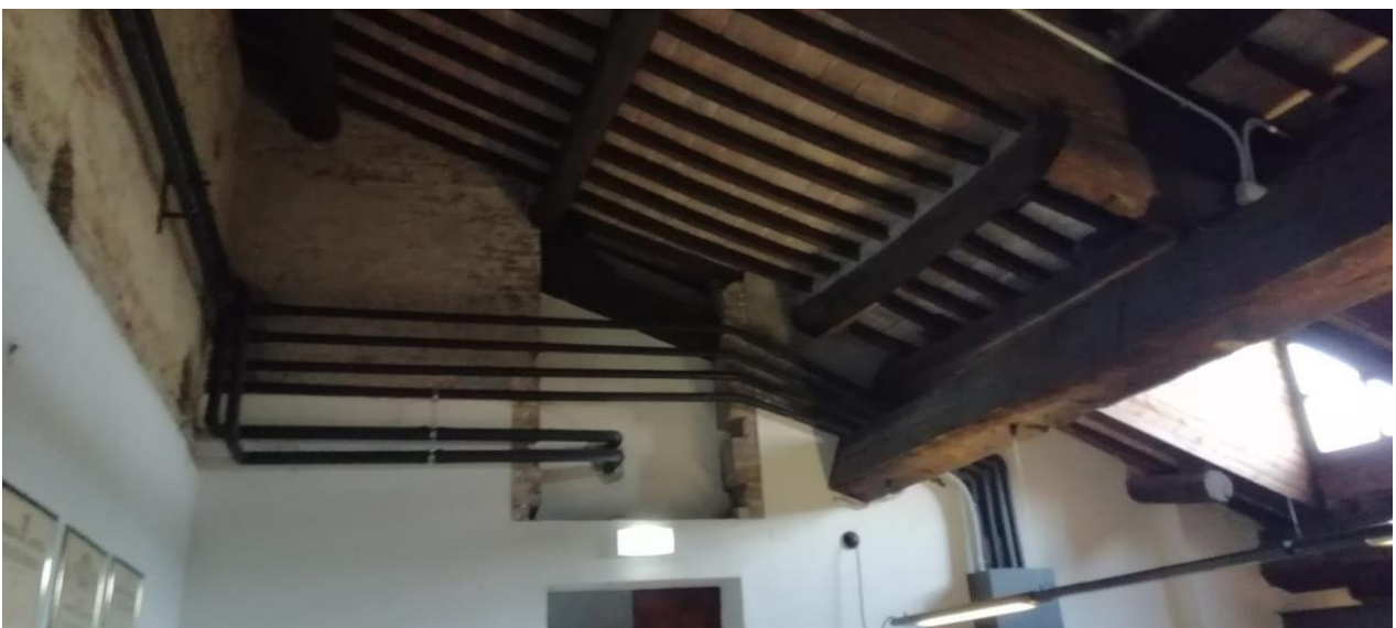
Figura 18- Sottotetto Corpo A con lucernari e arcarecci sezionati
