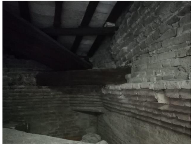
Figura 16 – Strutture di sottotetto con bilanciamento dello sporto di fronda e struttura in legno con tracantone
