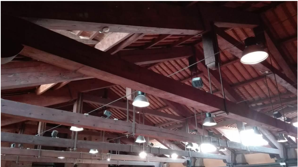
Figura 1 – Vista della copertura in legno della sala scenografica con capriate e arcarecci
