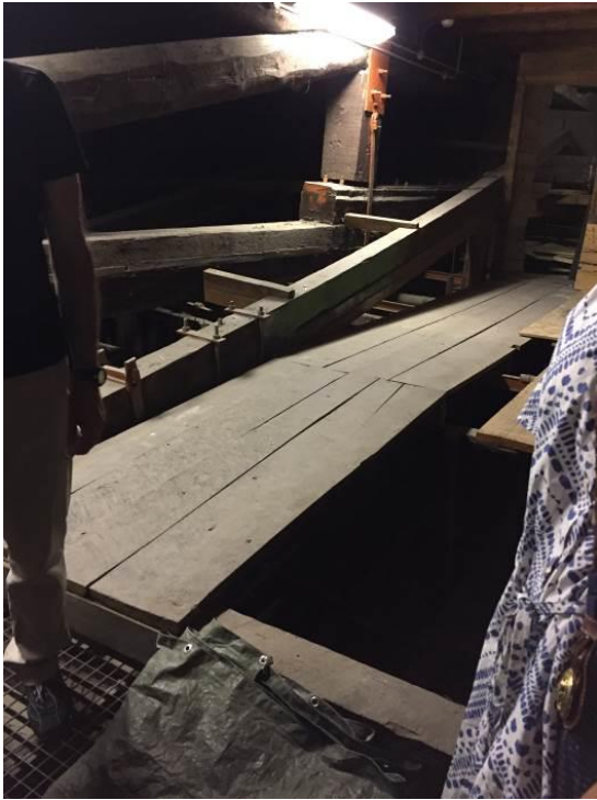
Figura 14 – Struttura portante del soffitto della platea e meccanismo dell'astrolampo (lampadario centrale)
