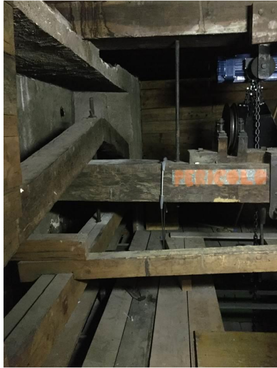
Figura 14 – Struttura portante del soffitto della platea e meccanismo dell'astrolampo (lampadario centrale)
