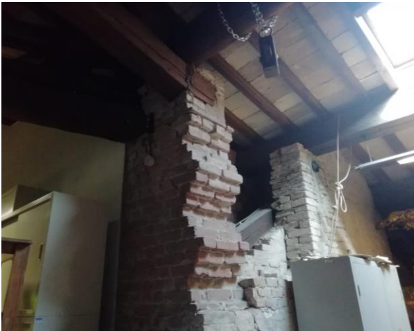
Figura 16 – Strutture di sottotetto con bilanciamento dello sporto di fronda e struttura in legno con tracantone
