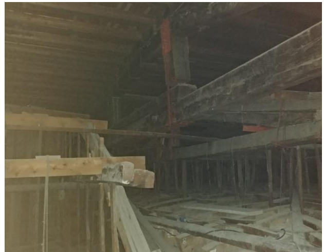
Figura 16 – Strutture di sottotetto con bilanciamento dello sporto di fronda e struttura in legno con tracantone
