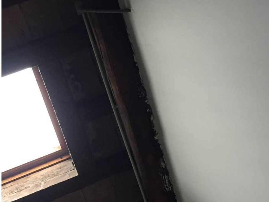
Figura 121 – Lucernario in copertura
