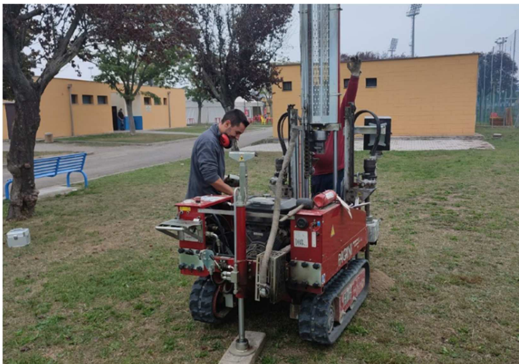
Foto n° 1 – esecuzione prova CPT
