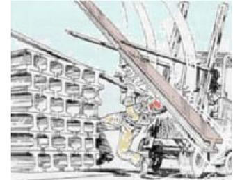
essere tenuti in condizioni di equilibrio stabile (ad esempio riposti in contenitori o assicurati al corpo dell'addetto) e non dovranno ingombrare posti di passaggio o di lavoro. I depositi di materiali in cataste, pile e mucchi dovranno essere organizzati in modo da evitare crolli o cedimenti e permettere una sicura e agevole movimentazione.
