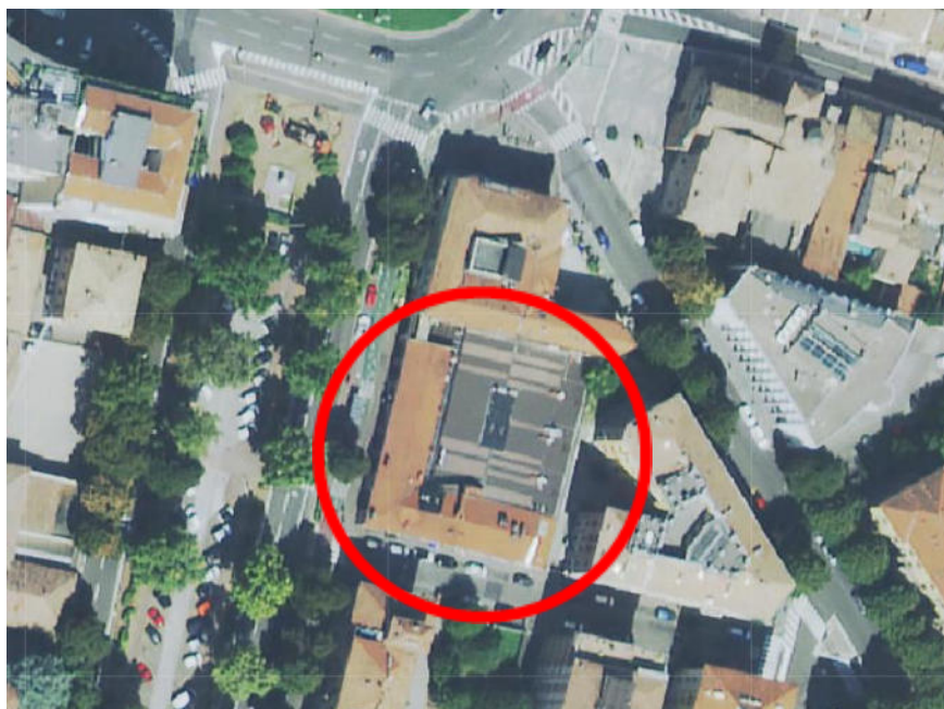
Figura 1 – Foto aerea dell'edificio oggetto di intervento, identificato con cerchio rosso.
