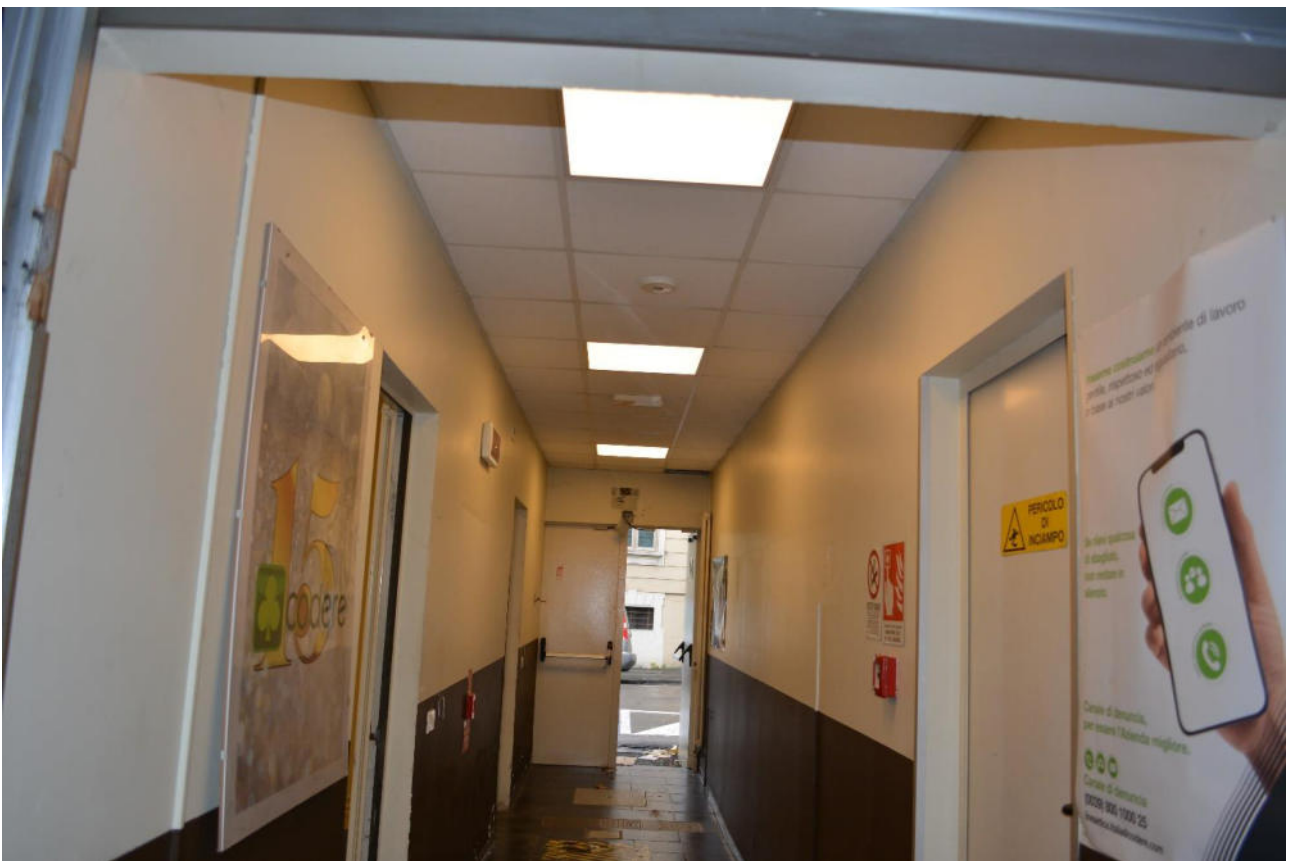
Disimpegno area di servizio
