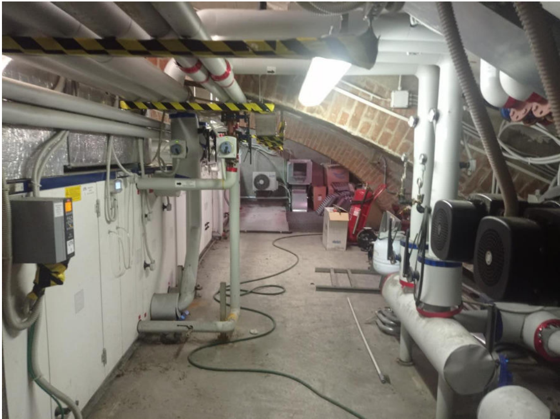
Locale tecnico piano primo/sottotetto
