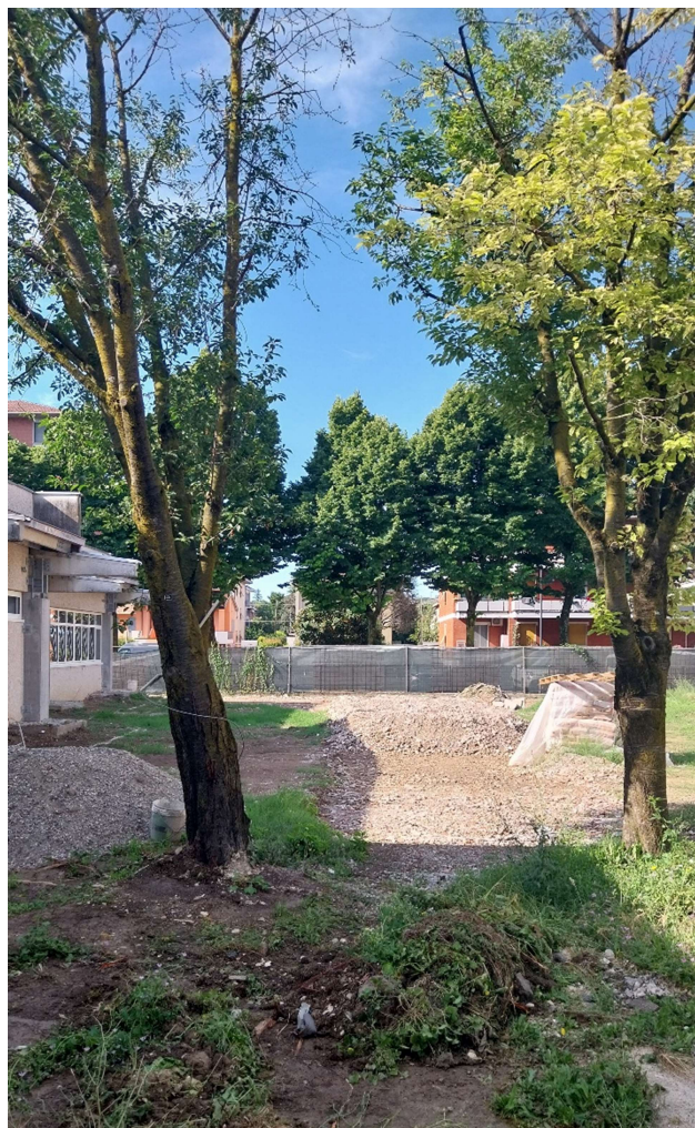
Figura 4- Vista dell'area dove viene realizzato il teatro
