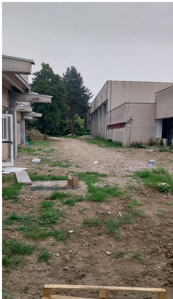
Figura 5- Vista dell'area per la realizzazione del teatro
