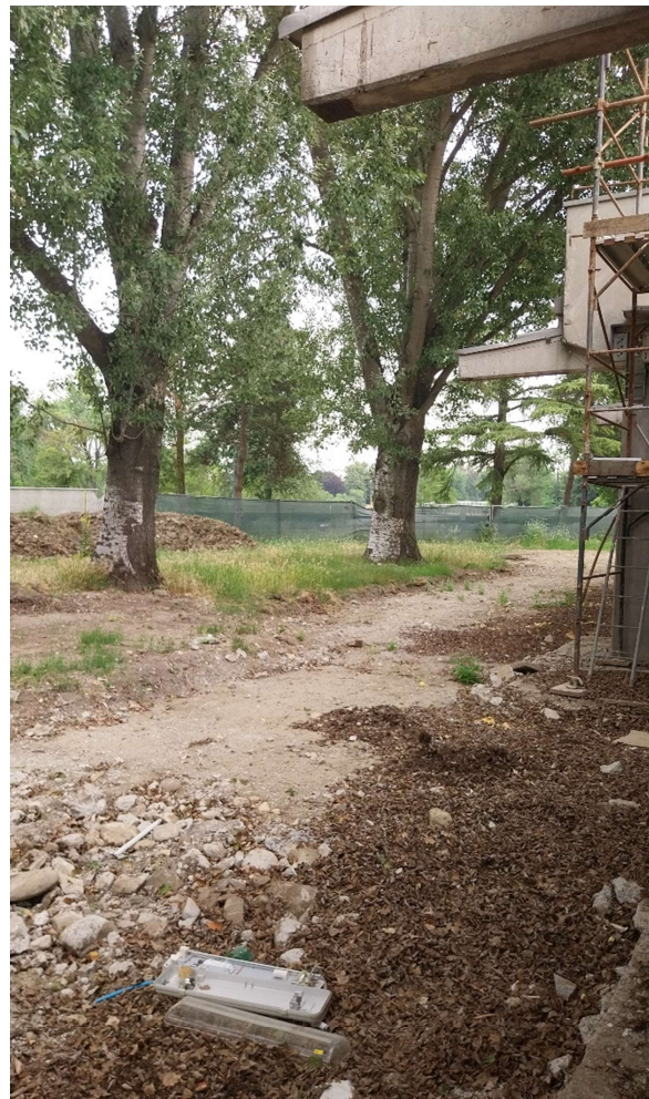
Figura 7- Vista dell'area dove viene realizzata l'aula
