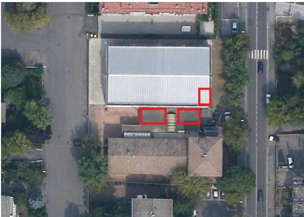
Foto 01 – Vista aerea con individuazione delle aree di lavoro (interne all'edificio)
