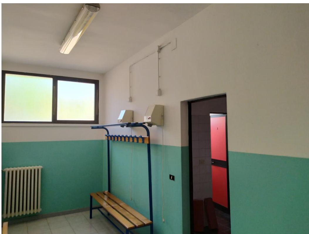
Figura 7 - Spogliatoi maschili oggetto di manutenzione straordinaria
