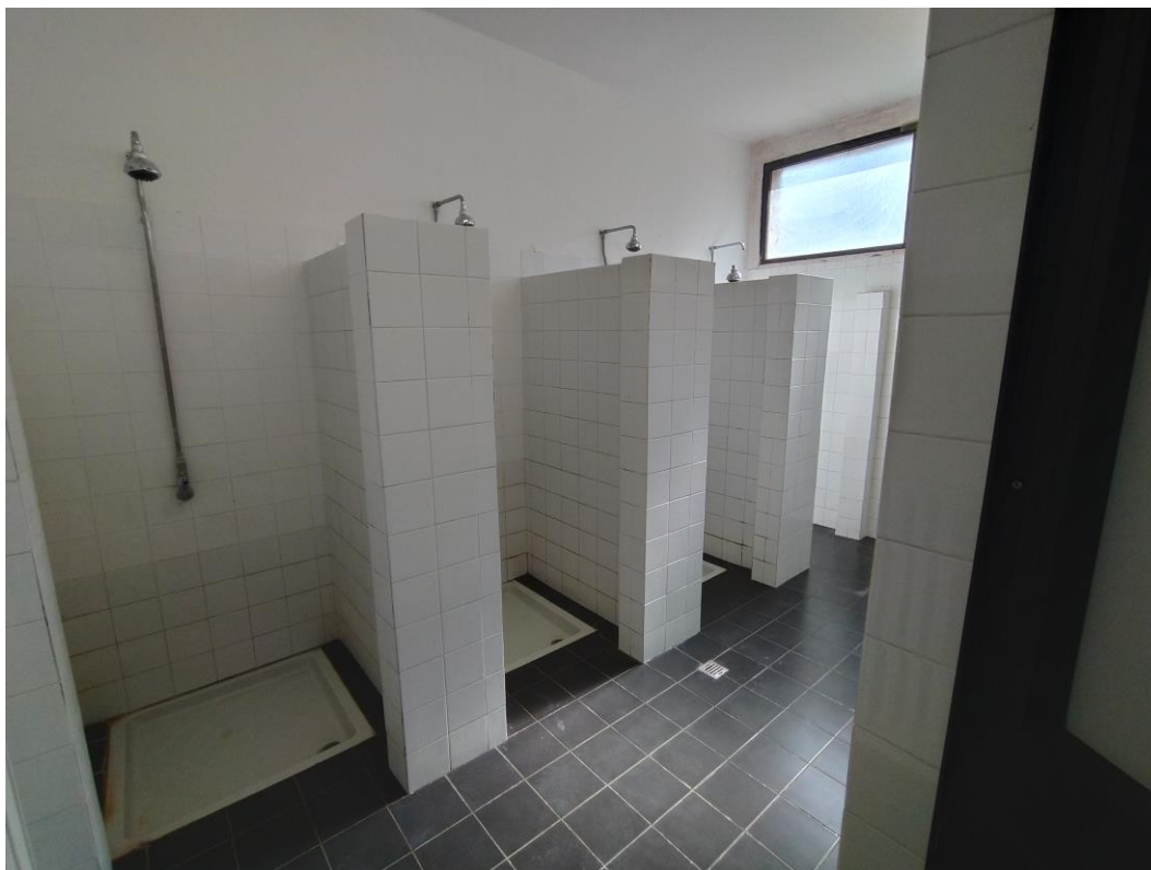
Figura 8 - Docce oggetto di manutenzione straordinaria
