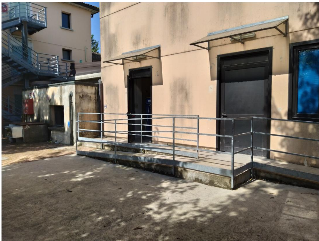
Figura 2 - Ingresso all'area di cantiere esterna
