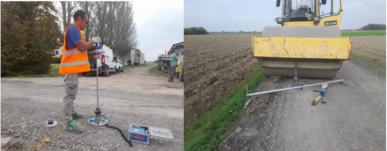
Esempio di prove di portanza dei sottofondi (piastra dinamica e piastra statica)
