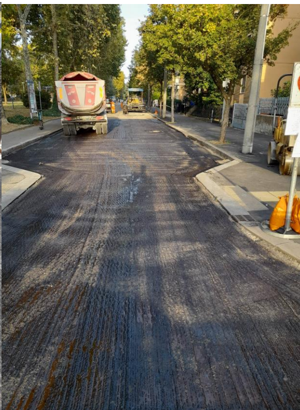
Foto 1 fase di fresatura
