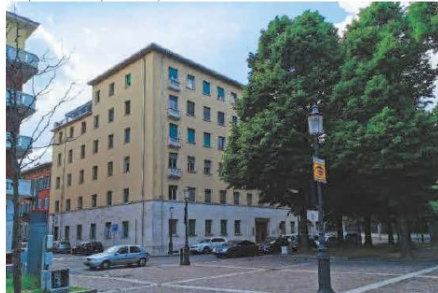
Figura 1. Foto Fonte: Regione Emilia-Romagna sopralluogo 2021
