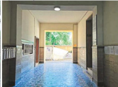
Figura 2. Foto Fonte: Regione Emilia-Romagna sopralluogo 2021
