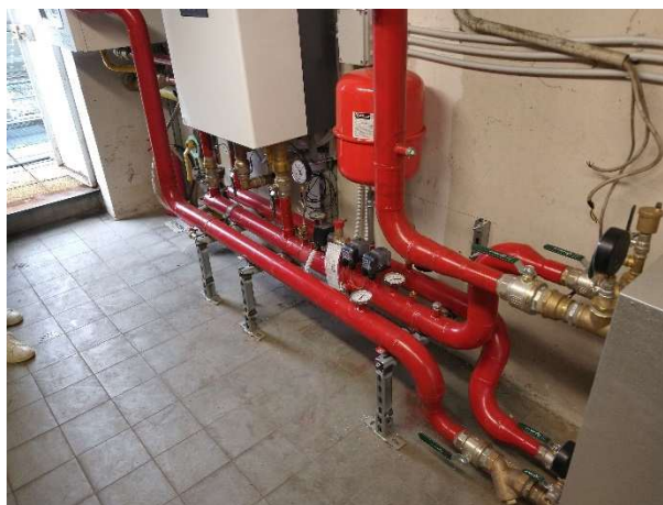
Circuito primario caldaie
