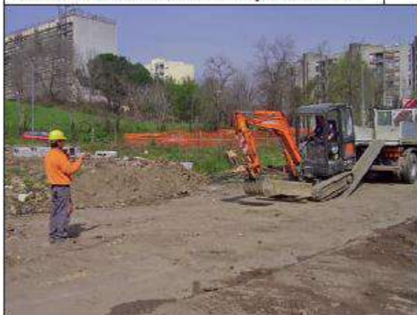
Discesa del miniescavatore con pedane mobili
