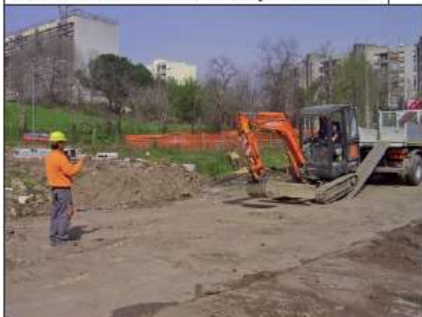
Discesa del miniescavatore con pedane mobili
