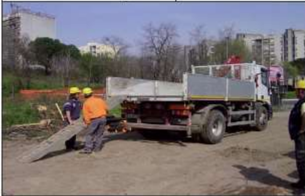
Rimozione seconda pedana
