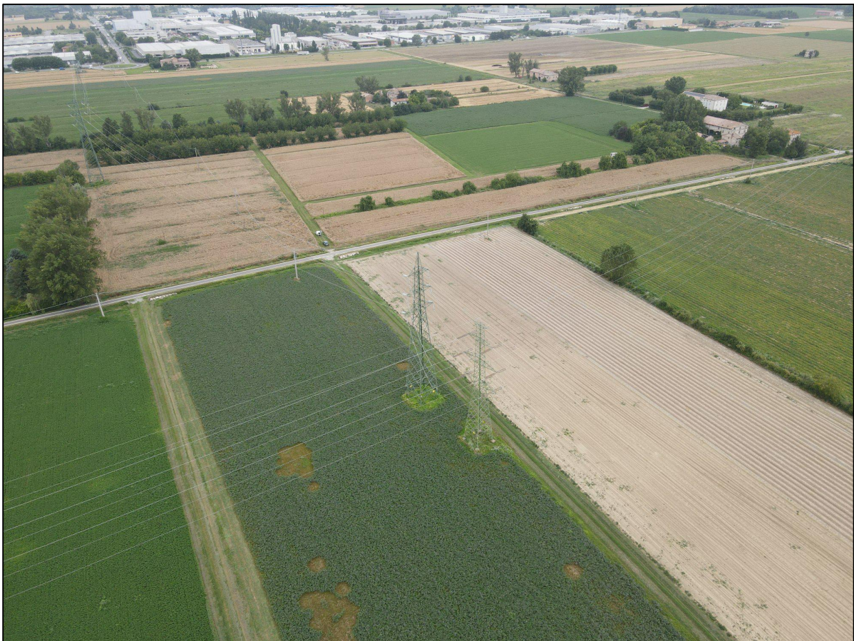
Cattura da drone eseguita con visuale in direzione quartiere SPIP. In primo piano sono visibili i cavidotti a media tensione antistanti Strada Pedrignano e il Cavo Canaletto. In secondo piano sono visibili i filari arborei da preservare e il quartiere SPIP.
