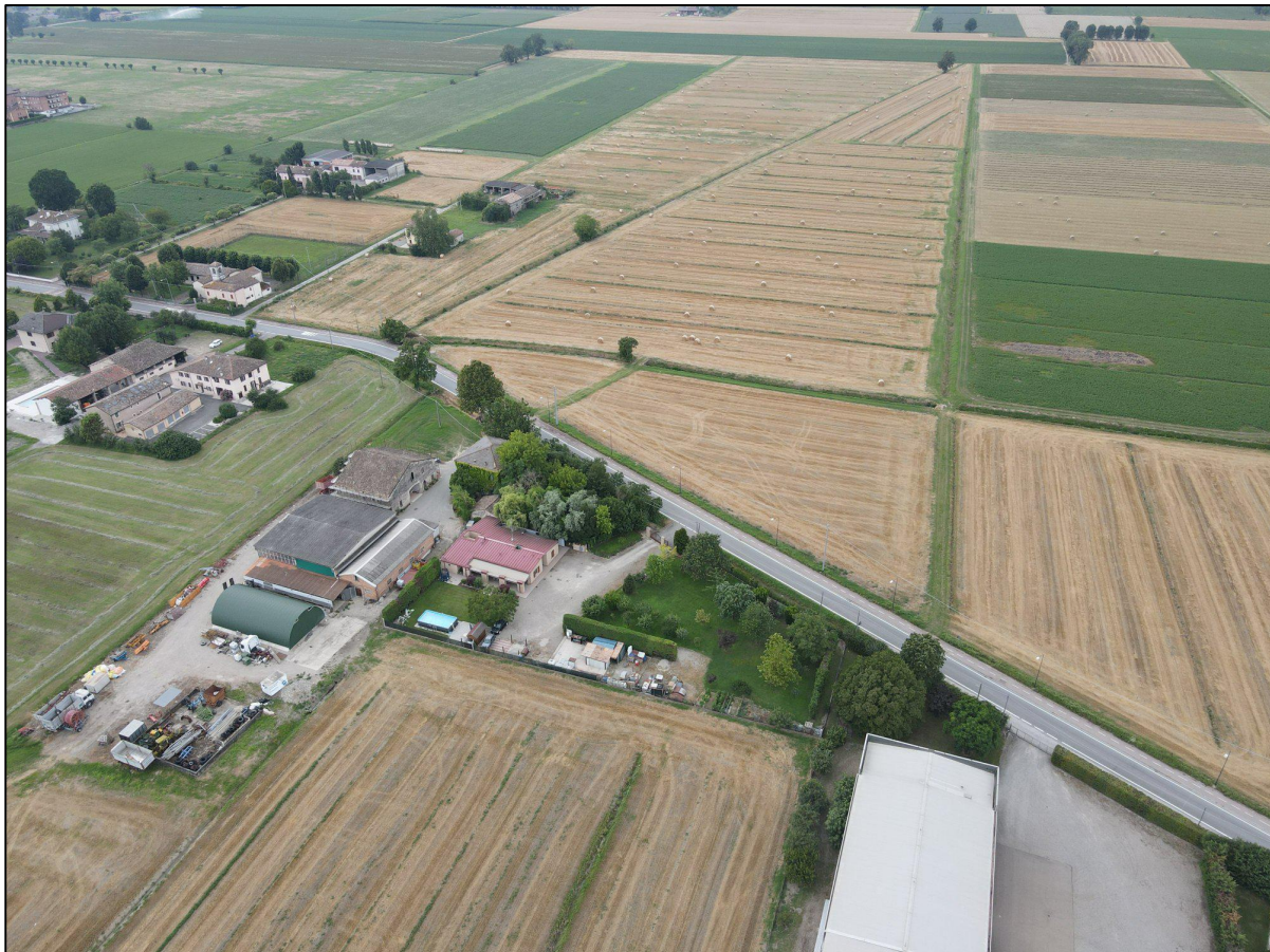
Cattura da drone raffigurante la porzione Orientale dell'area di intervento. Nello specifico è immortalata l'ubicazione della rotonda di progetto costeggiante Strada di Chiozzola.
