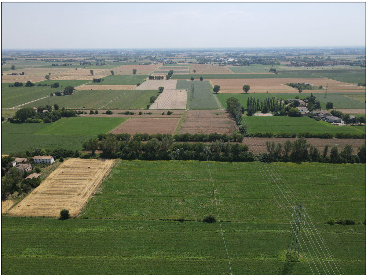
Cattura da drone eseguita al di sopra della rotonda esistente in Via Benjamin Franklin. Visuale in direzione dello sviluppo dell'asse viario di progetto in direzione Bogolese.
