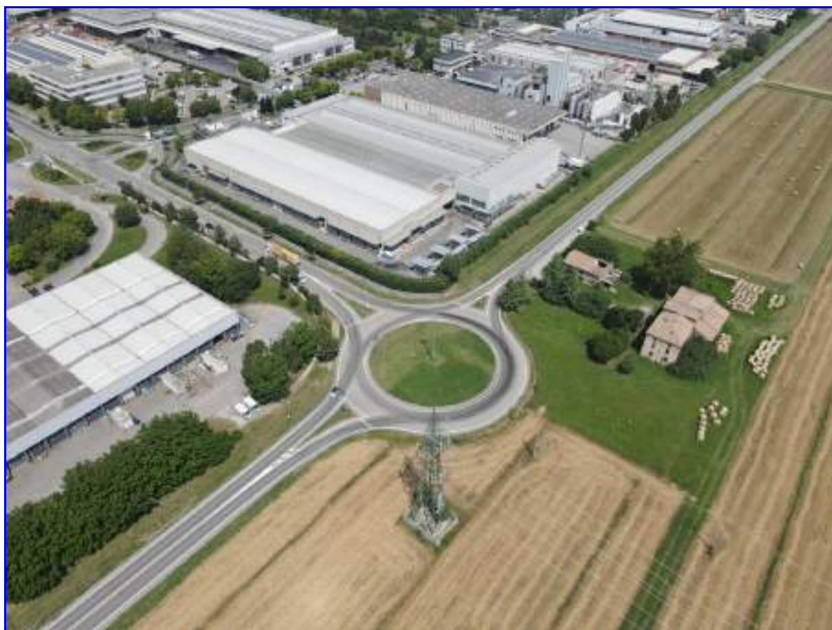
Fotografia 1-int – Vista porzione occidentale
